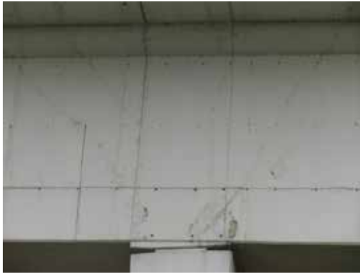
Fissuration à 45° des faces verticales des trémies de la partie aérienne.
