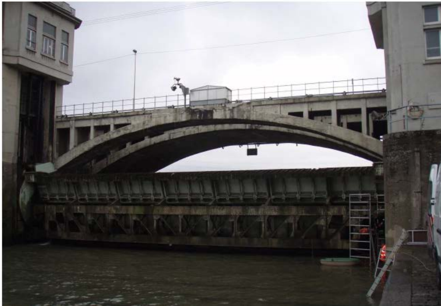
Vue d'un pertuis avec la vanne
