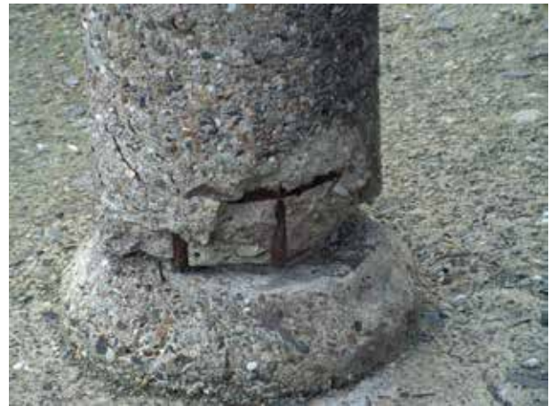
Pied de poteau d'éclairage en béton
