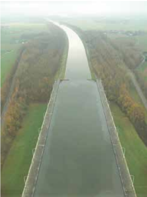
Les hauts remblais et le pont-canal amont vus depuis la tour de Ronquières
