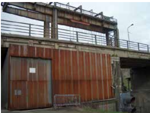
Marchienne - Portique aval
