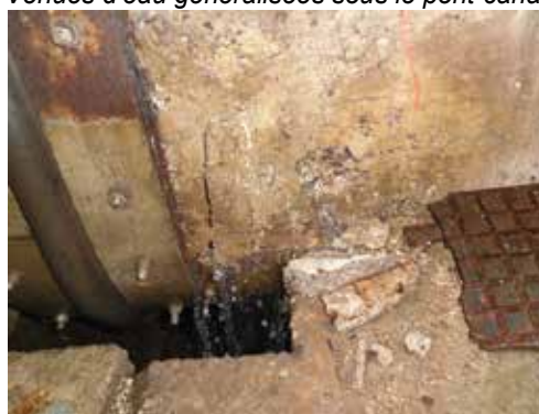
Venues d'eau généralisées sous le pont-canal
