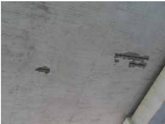
Chutes de plaques de béton sous les trémies de la partie aérienne et éclats localisés du béton des trémies.
