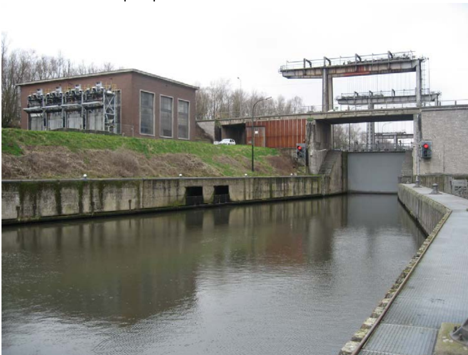
Marchienne - Station de pompage (à gauche) et tête aval de l'écluse (à droite)
