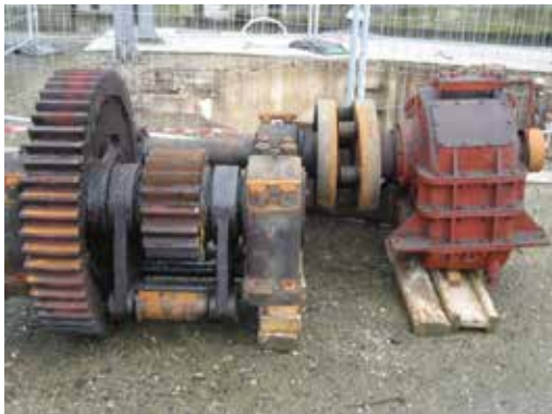
Gosselies - Treuil de vanne démonté
