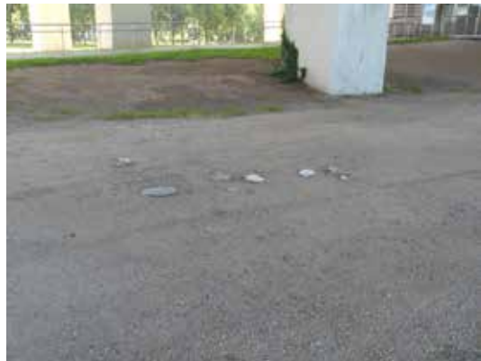
Chutes de plaques de béton sous les trémies de la partie aérienne et éclats localisés du béton des trémies.
