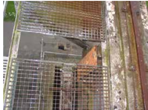
Passerelle d'un portique
