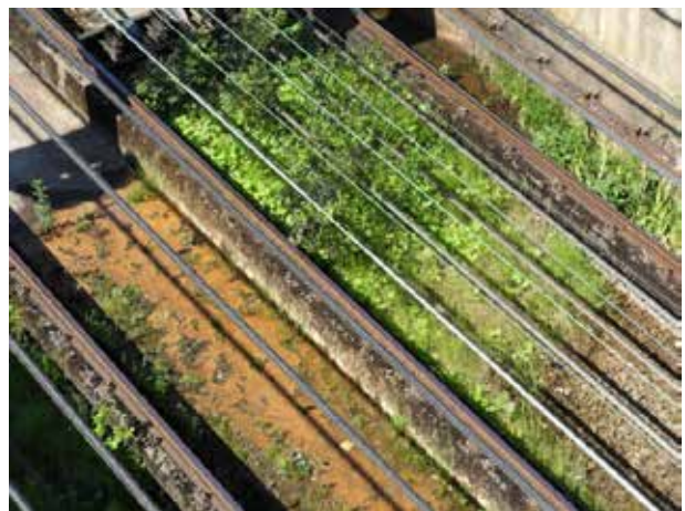
Chemin de roulement d'un contrepoids
